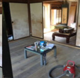
全部剥がした部屋
